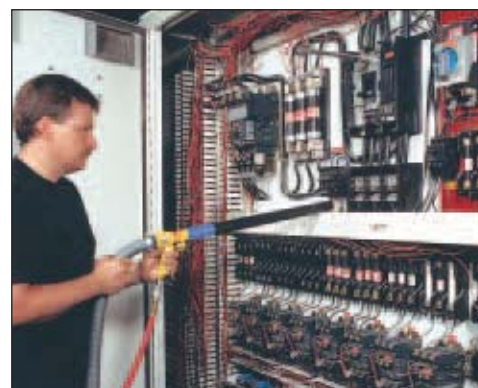
Der Hand-E-Vac Fördersatz ist ideal für das Reinigen von Elektroschränken.
